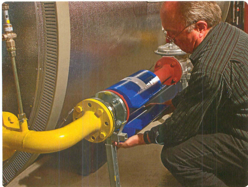
Die eigentliche Installation des Ecojet dauert nur wenige Minuten und das System an sich ist komplett wartungsfrei.
