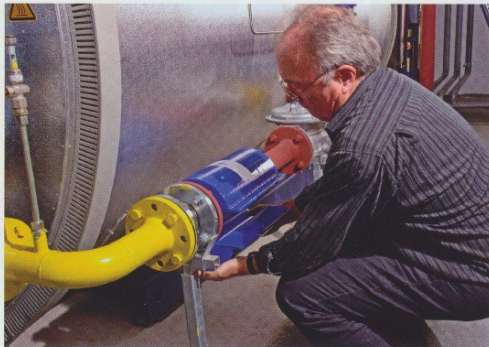
Der Ecojet kann im laufenden Betrieb installiert werden.
