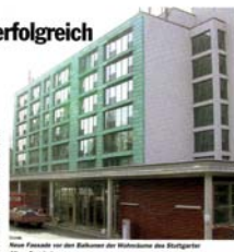
Neue Fassade vor dem Neubau der Wohnhäuser der Stuttgarter Altenpflegeheim
